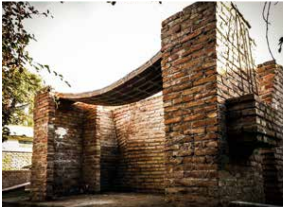
CATENARIA DE LADRILLO ARMADO
