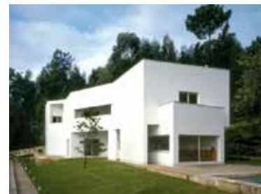
CASA VIEIRA DE CASTRO ALVARO SIZA. 1994 https://lucvazgal.files.wordpress.com/2012/11/011-181_425x4252.jpg
